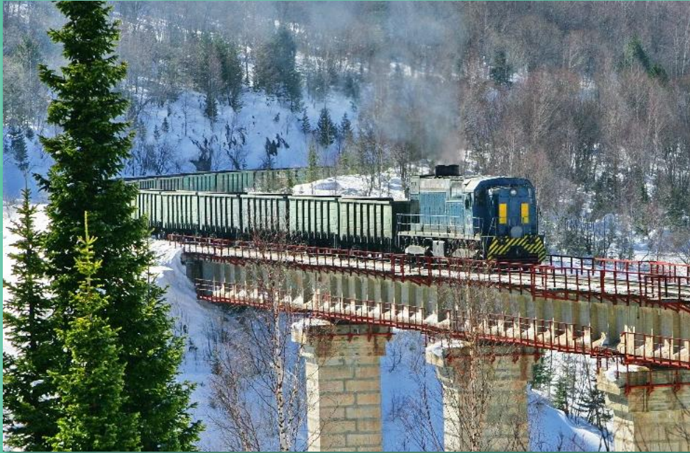
Подача/уборка, ПРР, маневровые работы
