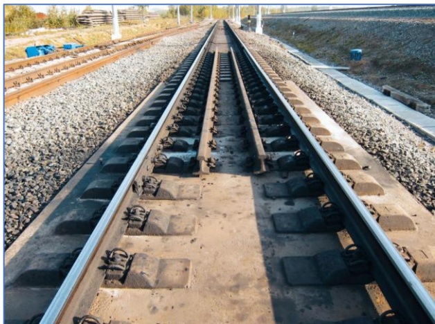
Безбалластный путь на зем.полотне
