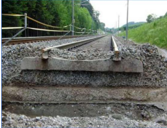
Безбалластный путь на зем.полотне
